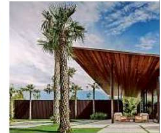
Beirais são uma marca registrada nas obras
