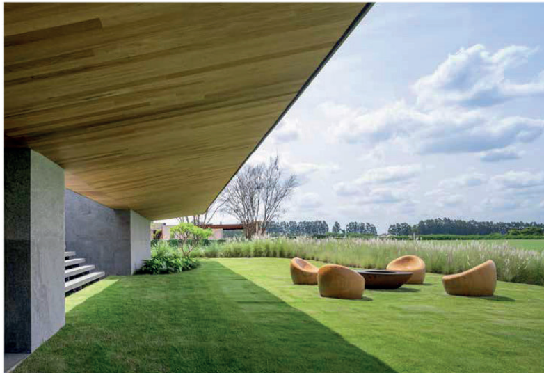
Det utskjutande taket skänker välbehövlig skugga under de varma årstiderna.
